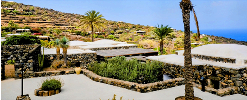
貴重な雨水を集めるために、白く丸いカーブの屋根が作られたダムーゾという家々が立ち並ぶパンテレリア島
